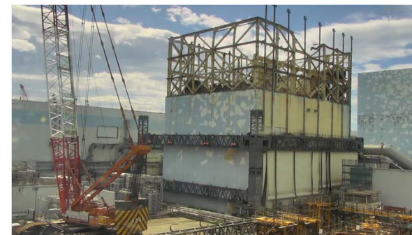
取り外し後の原子炉建屋
