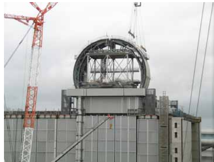
ドーム屋根 吊り下ろし完了
