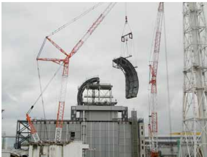
ドーム屋根吊り上げ中
