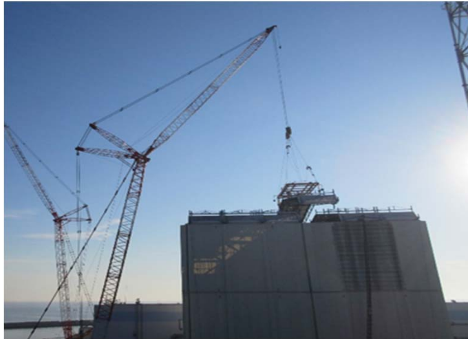
【2015年7月28日：屋根パネル1枚目取り外し】
