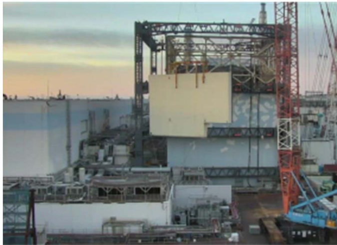
【2016年11月10日：壁パネル取り外し完了】
