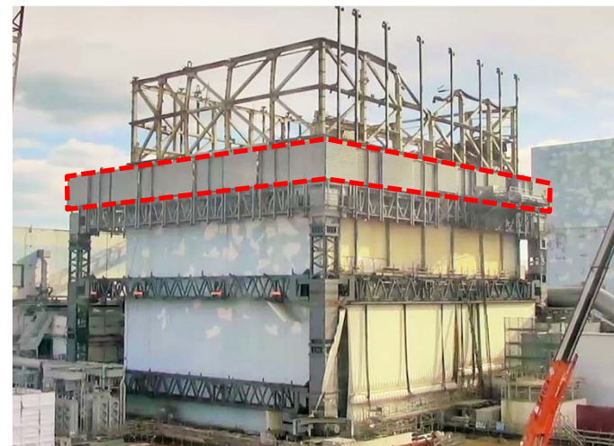
【2017年12月19日：防風フェンス取り付け完了】
