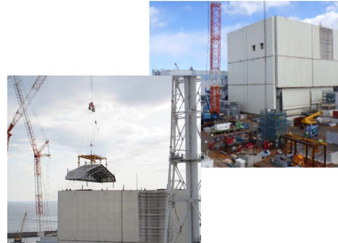
【2015年10月5日：屋根パネル取り外し完了】
