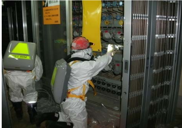
1号機 原子炉水位計校正(5/11)
