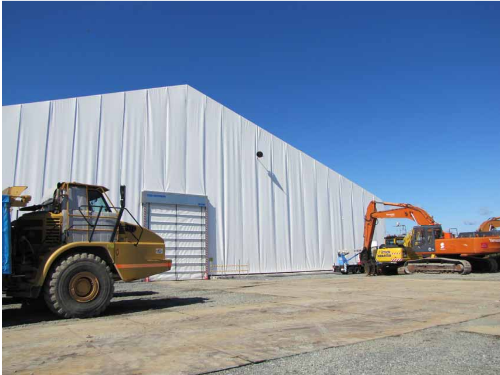
ガレキ保管テント（低線量用） 平成23年9月24日 当社社員撮影
