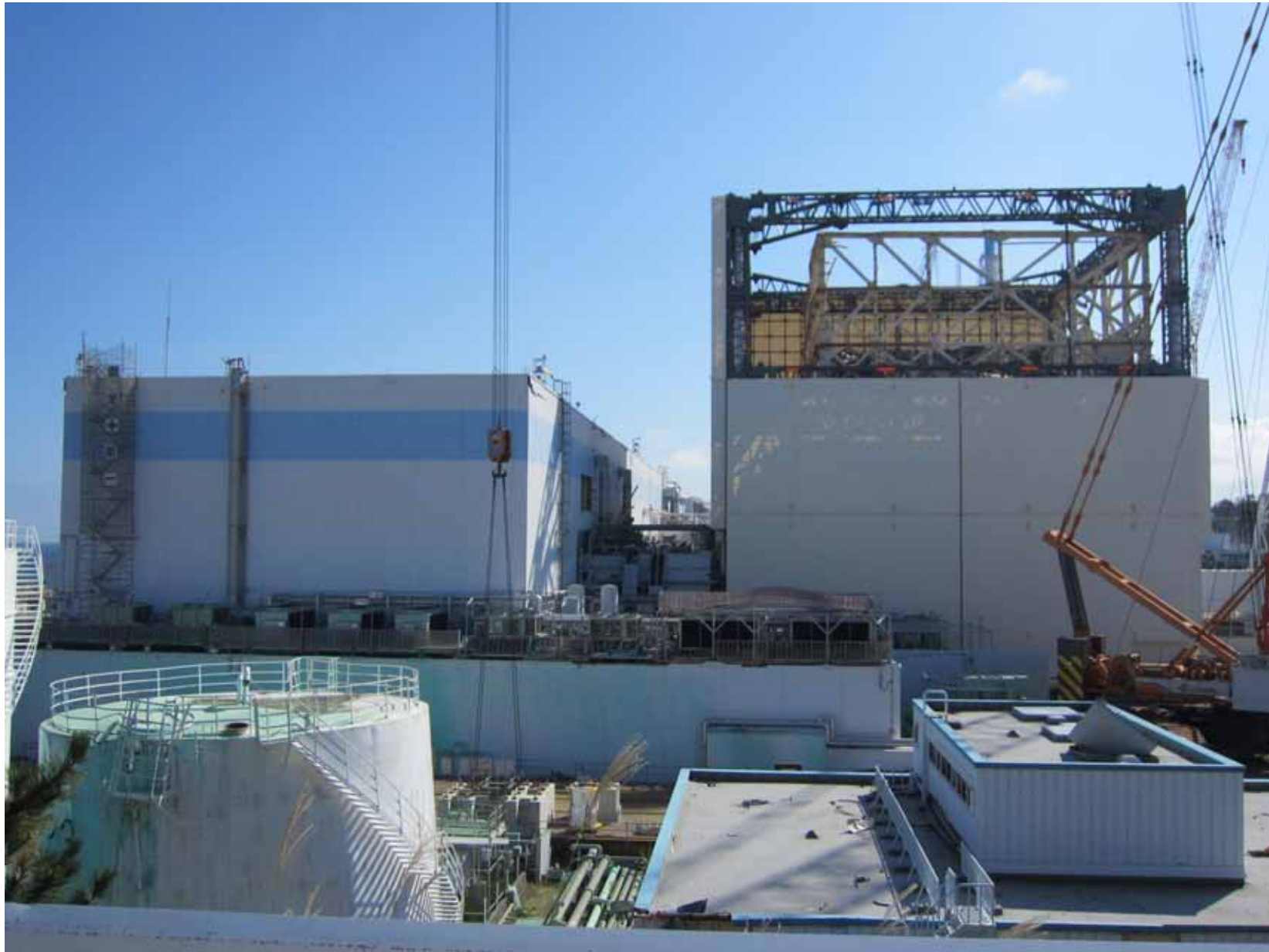
1号機原子炉建屋外観 ~ 1号機北側から撮影 ~ 平成23年9月29日 当社社員撮影
