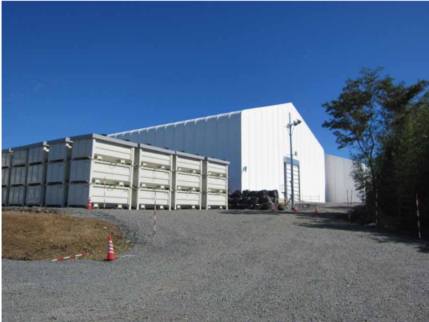
ガレキ保管コンテナとガレキ保管テント（高線量用） 平成23年9月24日 当社社員撮影
