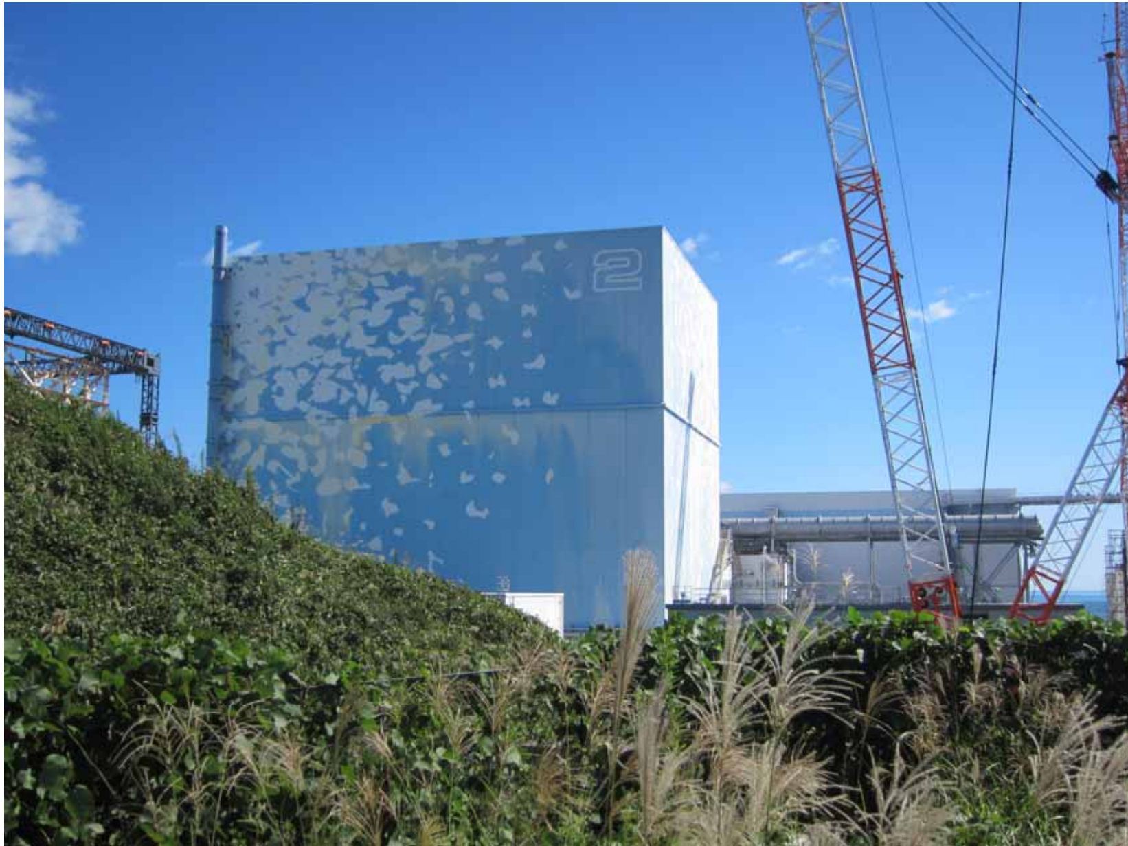
2号機原子炉建屋外観 ～ 2・3号機間西側高台から撮影～ 平成23年9月24日 当社社員撮影
