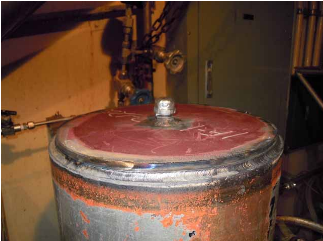
< 配管切断箇所下部 >
