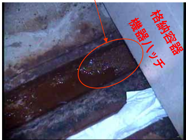
レール溝 格納容器機器ハッチ近傍
