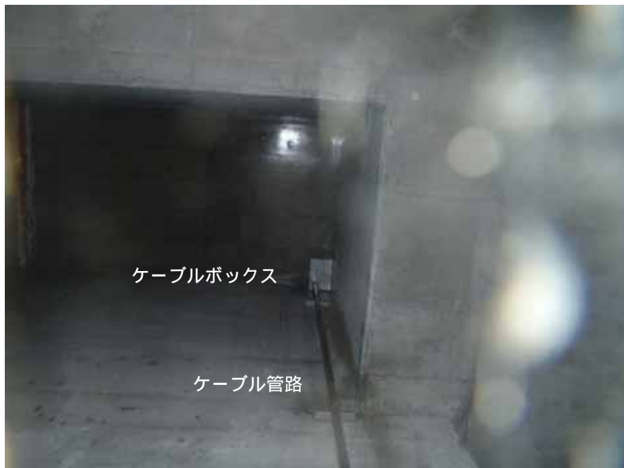
【写真】ケーブル管路を見上げた状態
