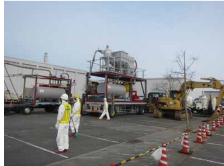
- 2 免震重要棟駐車場ダスト・小ガレキ集じん作業 平成24年1月9日 当社社員撮影
