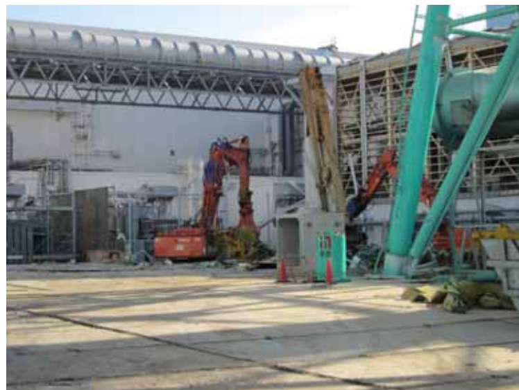
- 2 3・4号機原子炉建屋付近のガレキ撤去 平成24年1月10日 当社社員撮影
