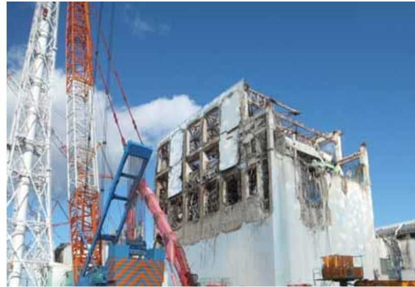
- 8 4号機原子炉建屋上部ガレキ撤去(作業後) 平成24年1月5日
