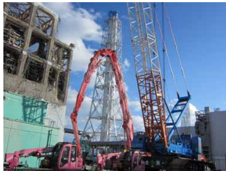
- 2 大型解体重機 平成24年1月14日 当社社員撮影
