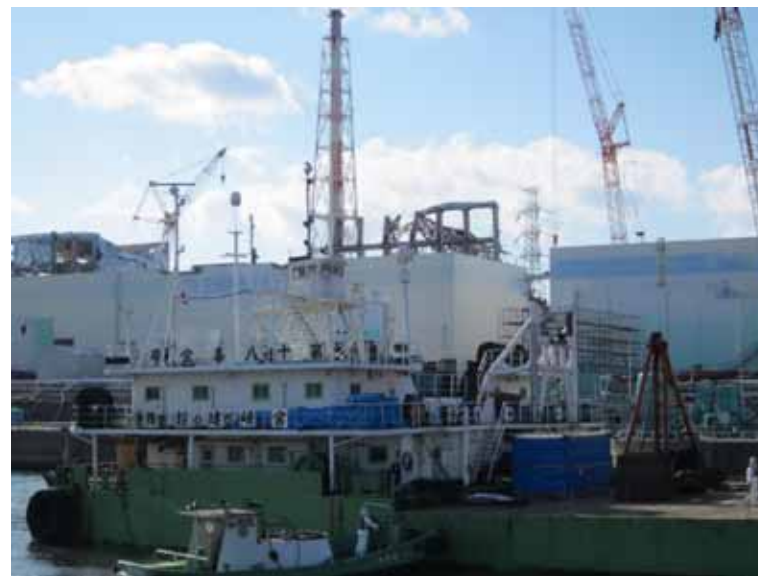
- 5 起重機船による支障物撤去作業(東防波堤より) 平成24年1月14日 当社社員撮影
