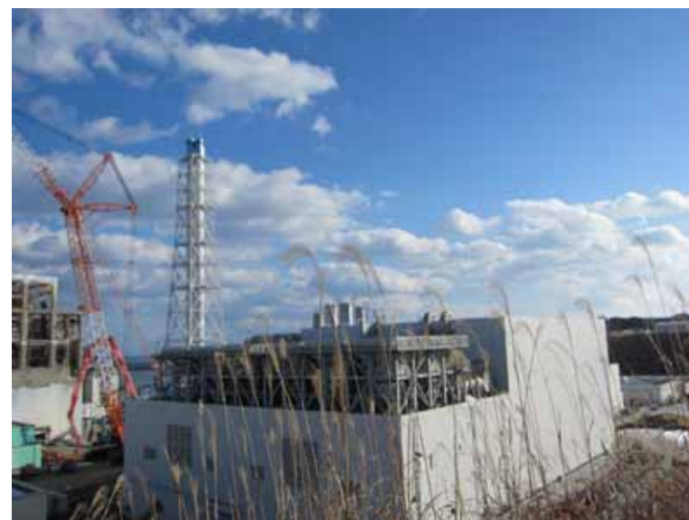
- 3 共用プール建屋 平成24年1月14日 当社社員撮影
