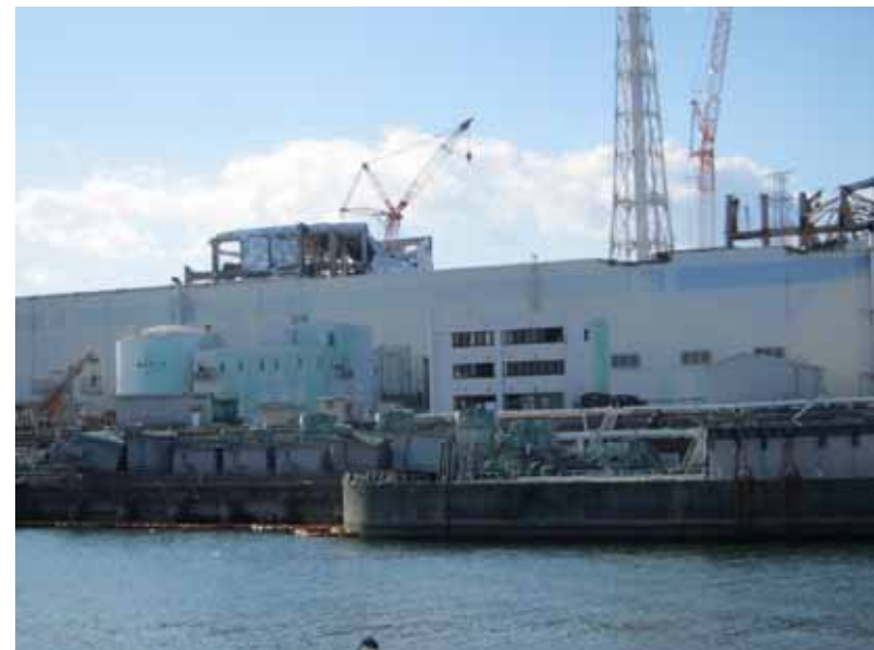
- 3 3・4号機タービン建屋(東防波堤より) 平成24年1月14日 当社社員撮影
