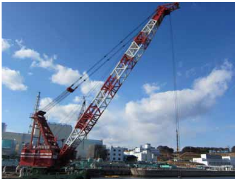
- 4 起重機船による支障物撤去作業(東防波堤より) 平成24年1月14日 当社社員撮影
