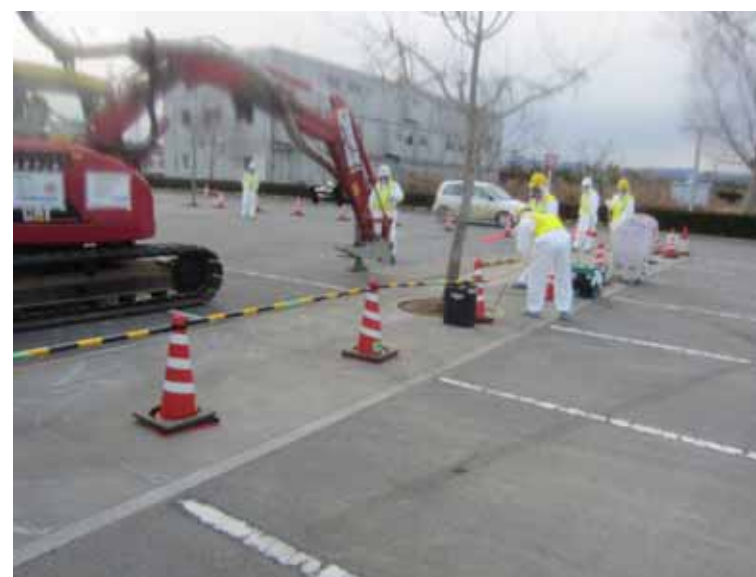
- 6 免震重要棟駐車場ダスト・小ガレキ集じん作業 平成24年1月9日 当社社員撮影
