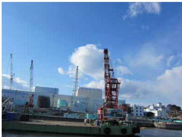
- 6 起重機船による支障物撤去作業(東防波堤より) 平成24年1月14日 当社社員撮影
