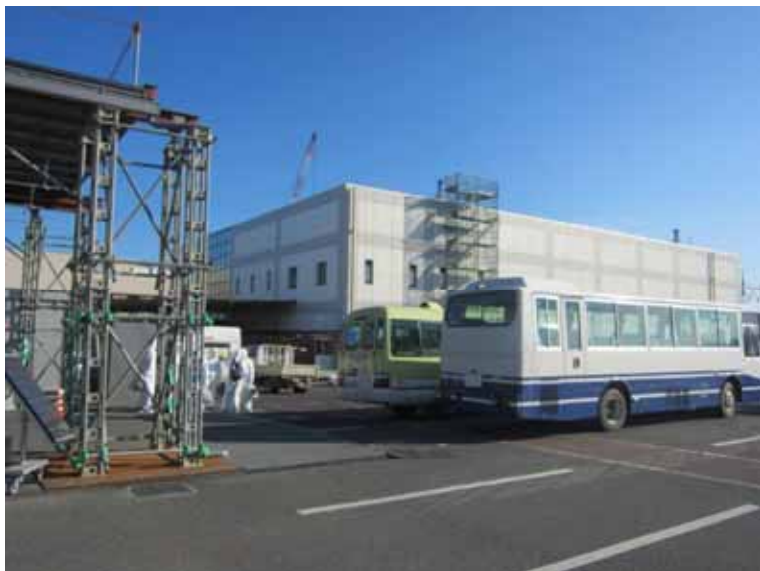
免震重要棟 平成24年1月18日 当社社員撮影
