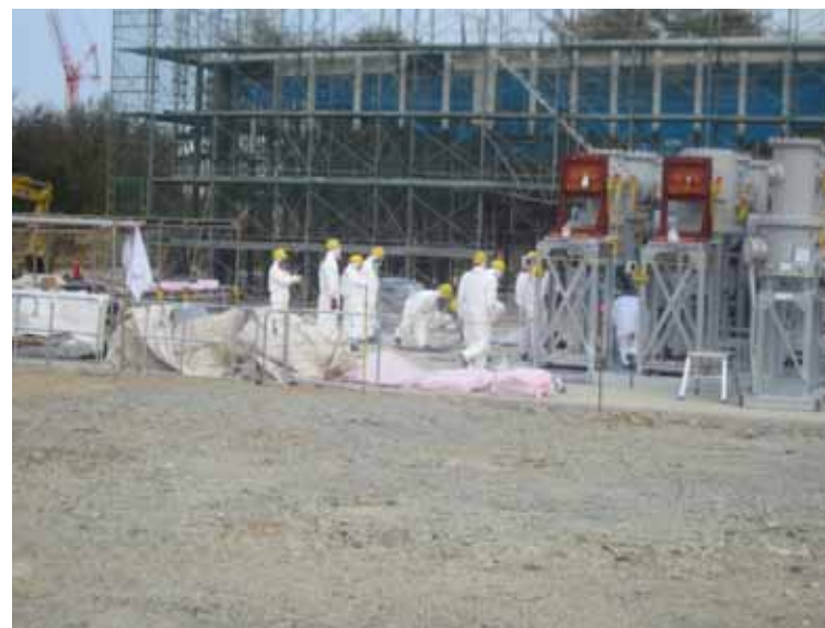
- 4 新開閉所建設 平成24年1月9日 当社社員撮影
