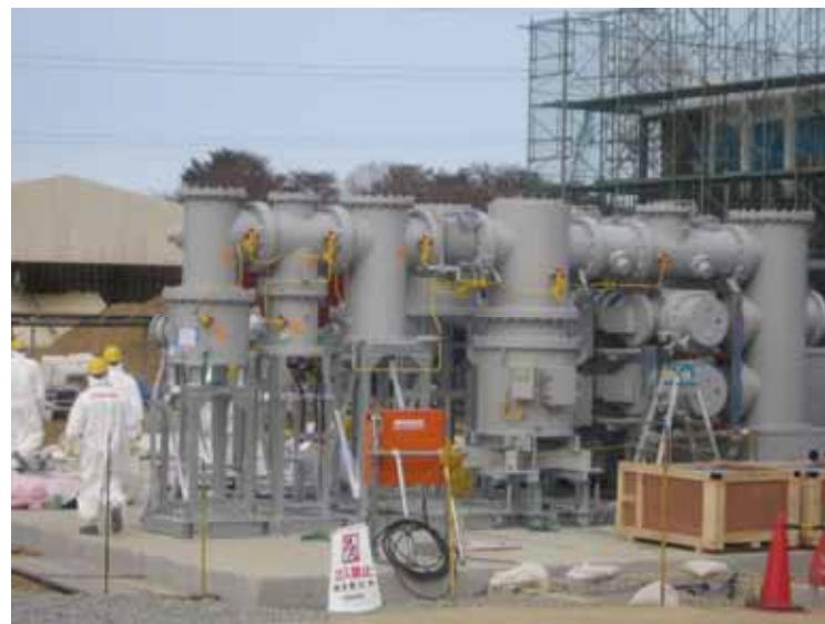
- 6 新開閉所建設 平成24年1月9日 当社社員撮影
