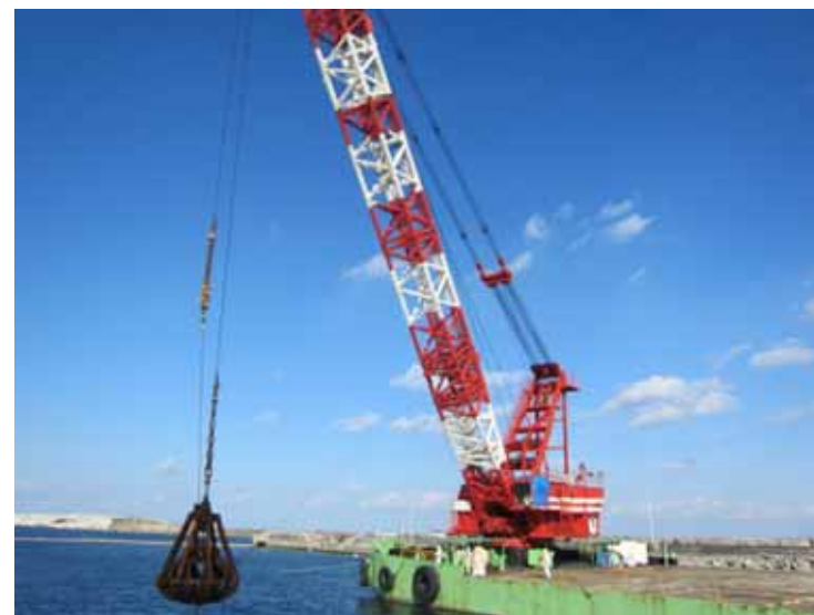
起重機船による支障物撤去作業(海側ヤードより) 平成24年1月14日 当社社員撮影
