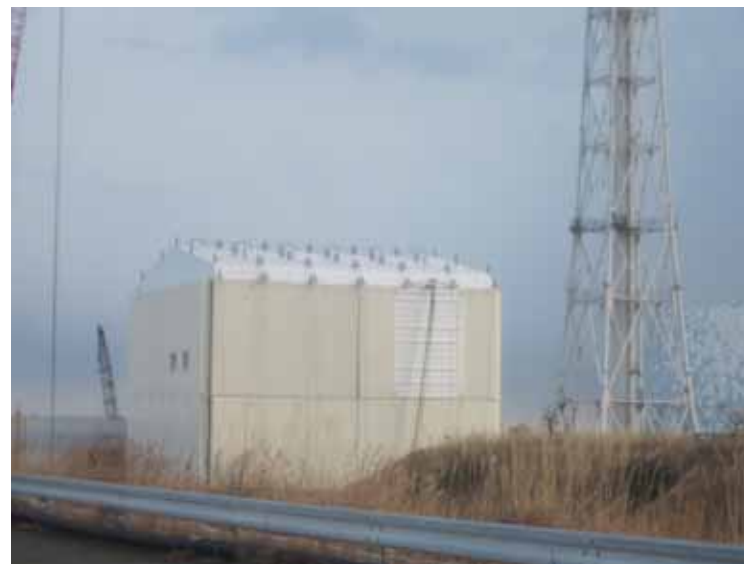
- 2 免震重要棟裏より1号機原子炉建屋を臨む 平成24年1月9日 当社社員撮影
