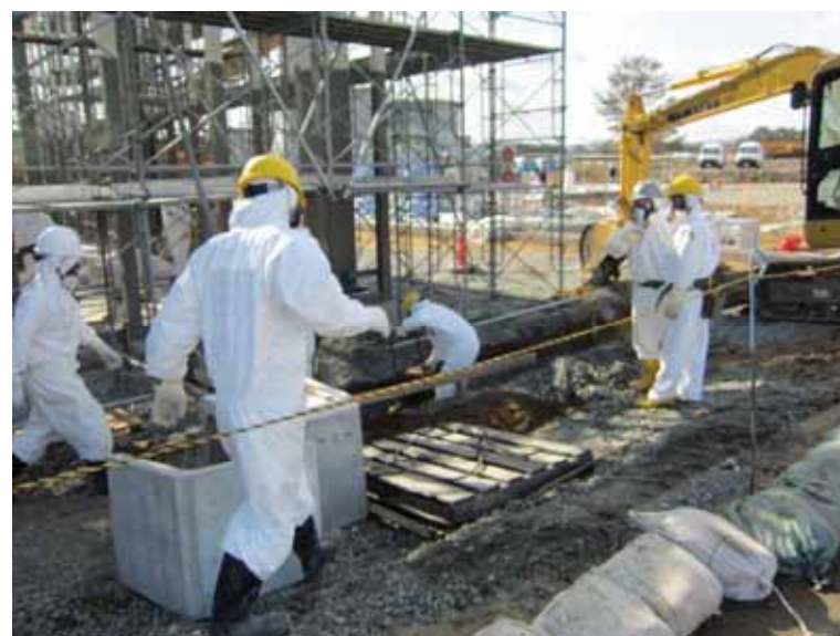
- 9 新開閉所建設 平成24年1月10日 当社社員撮影
