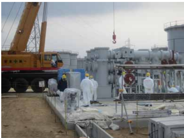
- 3 新開閉所建設 平成24年1月9日 当社社員撮影
