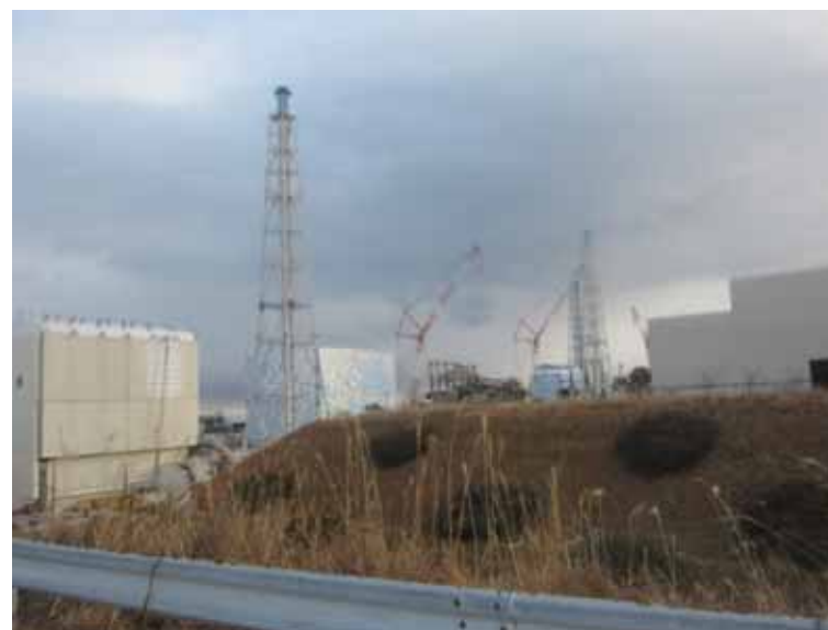
- 4 免震重要棟裏より2・3号機原子炉建屋を臨む 平成24年1月9日 当社社員撮影
