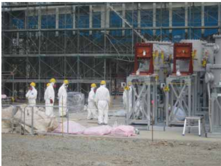
- 5 新開閉所建設 平成24年1月9日 当社社員撮影
