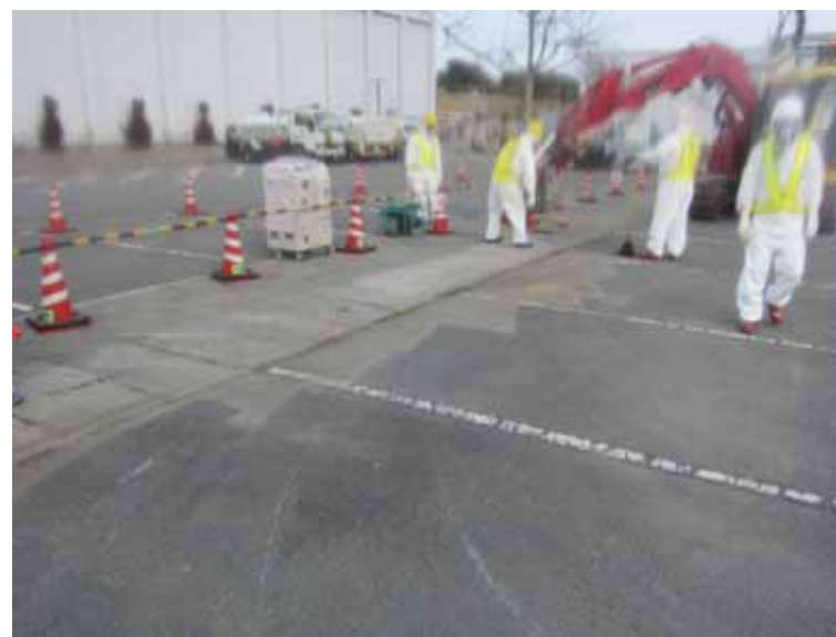
- 9 免震重要棟駐車場ダスト・小ガレキ集じん作業(作業後) 平成24年1月9日 当社社員撮影
