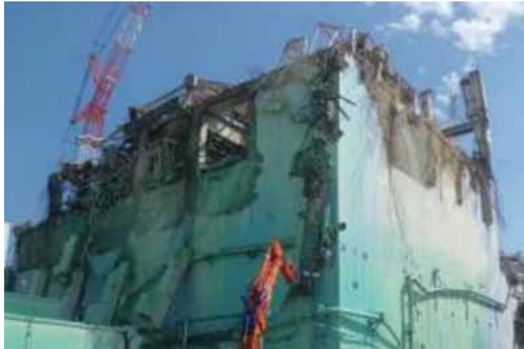
- 5 3号機原子炉建屋上部ガレキ撤去(作業前) 平成23年9月10日
