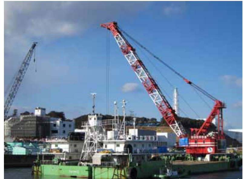
- 2 起重機船による支障物撤去作業(東防波堤より) 平成24年1月14日 当社社員撮影
