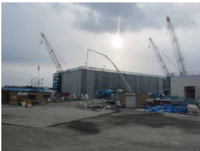
- 2 廃スラッジ貯蔵施設 平成24年1月9日 当社社員撮影
