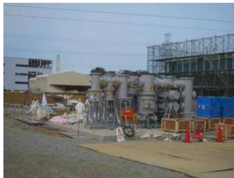
- 7 新開閉所建設 平成24年1月9日 当社社員撮影
