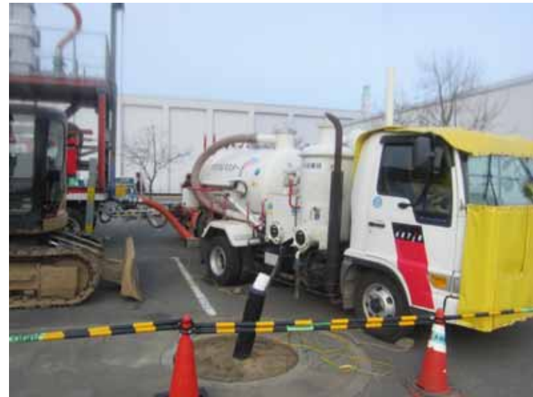
- 3 免震重要棟駐車場ダスト・小ガレキ集じん作業 平成24年1月9日 当社社員撮影
