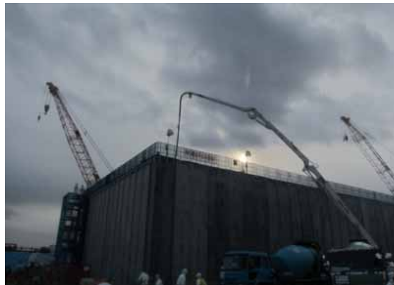
- 1 廃スラッジ貯蔵施設 平成24年1月9日 当社社員撮影
