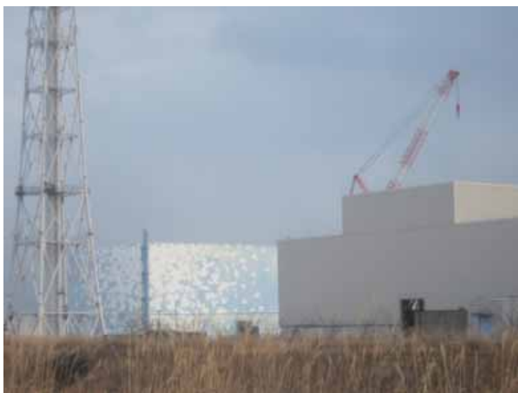
- 3 免震重要棟裏より2号機原子炉建屋を臨む 平成24年1月9日 当社社員撮影
