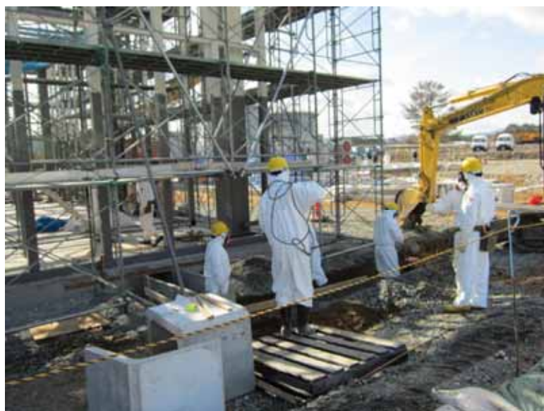
- 10 新開閉所建設 平成24年1月10日 当社社員撮影
