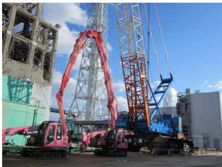
- 1 大型解体重機 平成24年1月14日 当社社員撮影
