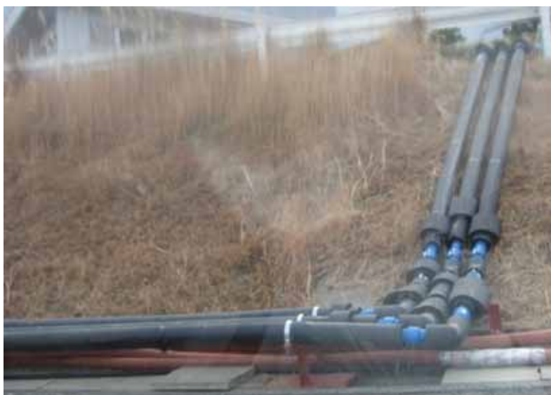
炉注水ホースの凍結防止対策 平成24年1月9日 当社社員撮影
