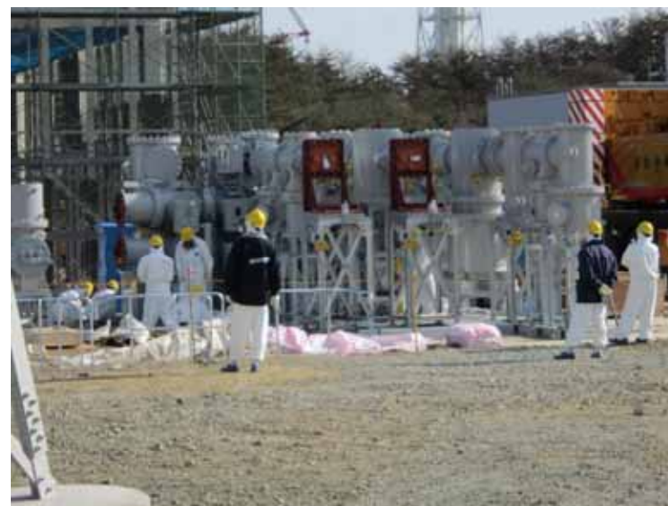
- 11 新開閉所建設 平成24年1月10日 当社社員撮影
