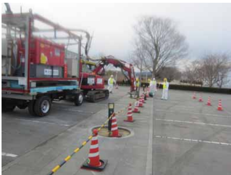
- 7 免震重要棟駐車場ダスト・小ガレキ集じん作業 平成24年1月9日 当社社員撮影
