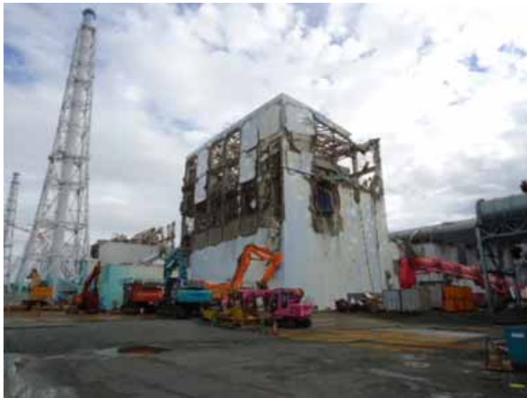
- 7 4号機原子炉建屋上部ガレキ撤去(作業前) 平成23年9月22日
