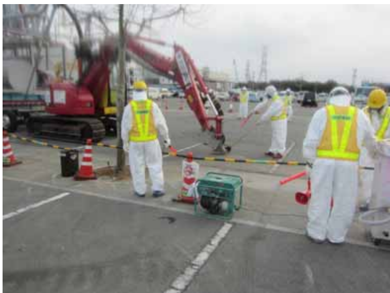
- 4 免震重要棟駐車場ダスト・小ガレキ集じん作業 平成24年1月9日 当社社員撮影
