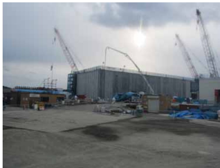
- 3 廃スラッジ貯蔵施設 平成24年1月9日 当社社員撮影
