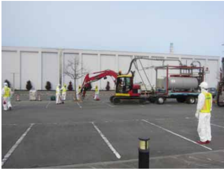
- 1 免震重要棟駐車場ダスト・小ガレキ集じん作業 平成24年1月9日 当社社員撮影
