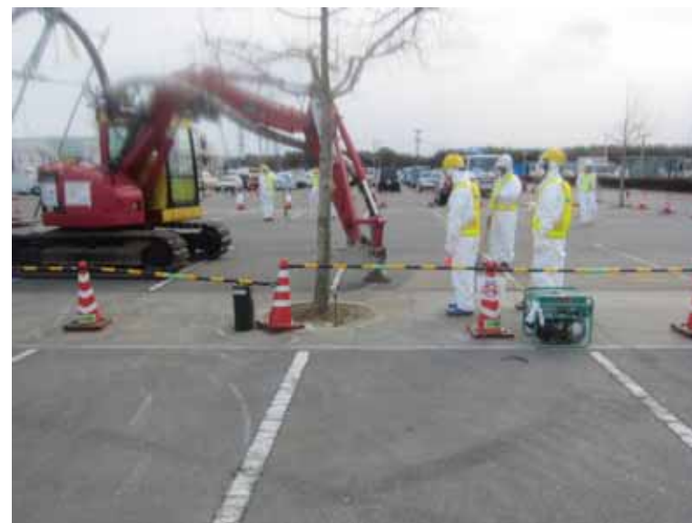
- 5 免震重要棟駐車場ダスト・小ガレキ集じん作業 平成24年1月9日 当社社員撮影
