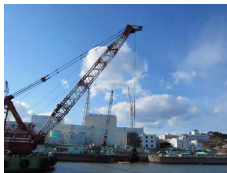
- 7 起重機船による支障物撤去作業(東防波堤より) 平成24年1月14日 当社社員撮影
