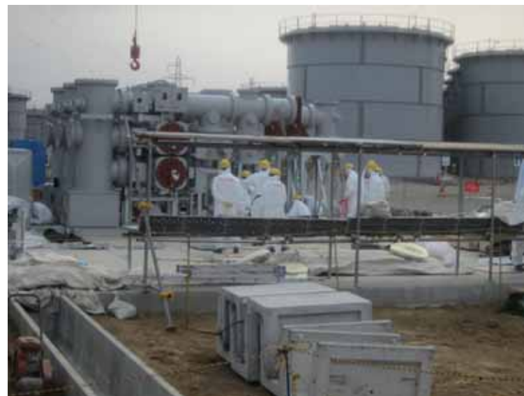
- 2 新開閉所建設 平成24年1月9日 当社社員撮影
