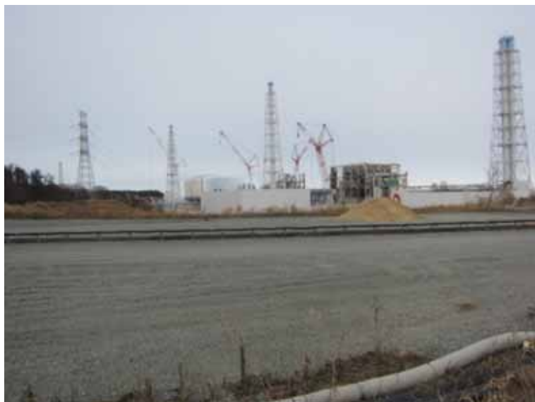
- 1 4号機南側高台より 平成24年1月9日 当社社員撮影
