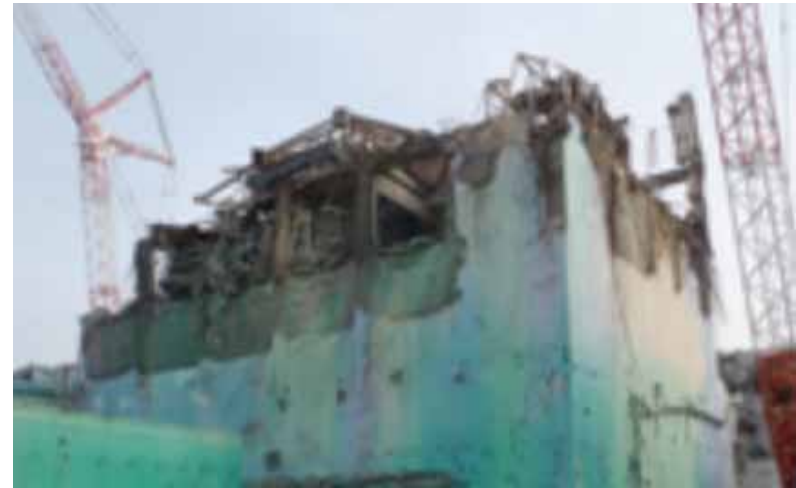
- 6 3号機原子炉建屋上部ガレキ撤去(作業後) 平成23年12月2日
