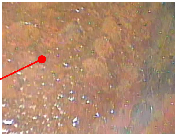
原子炉格納容器内壁
