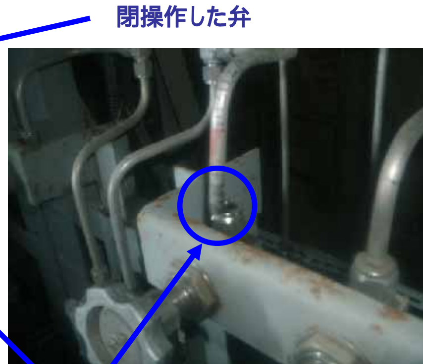
漏えい箇所の拡大図 漏えい箇所
