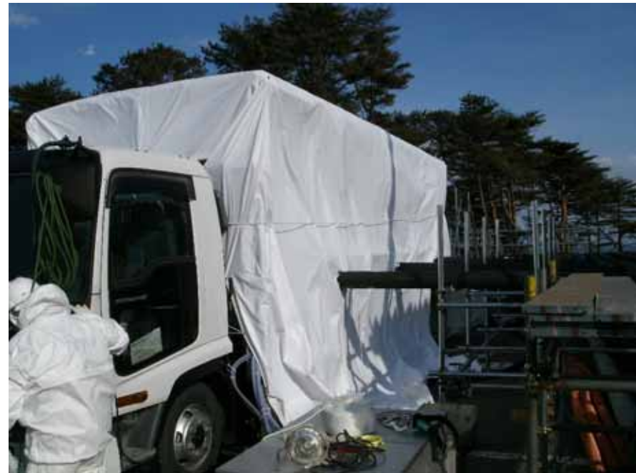
カバー設置状況
