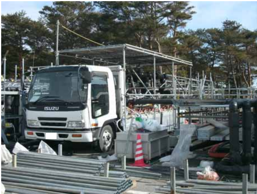
枠組み設置状況
