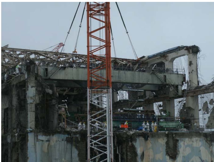
⑤ 天井クレーンガーダー撤去作業(1)
