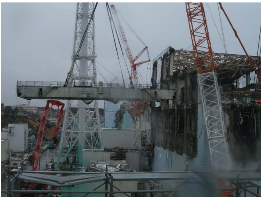
⑦ 天井クレーンガーダー撤去作業(3)
