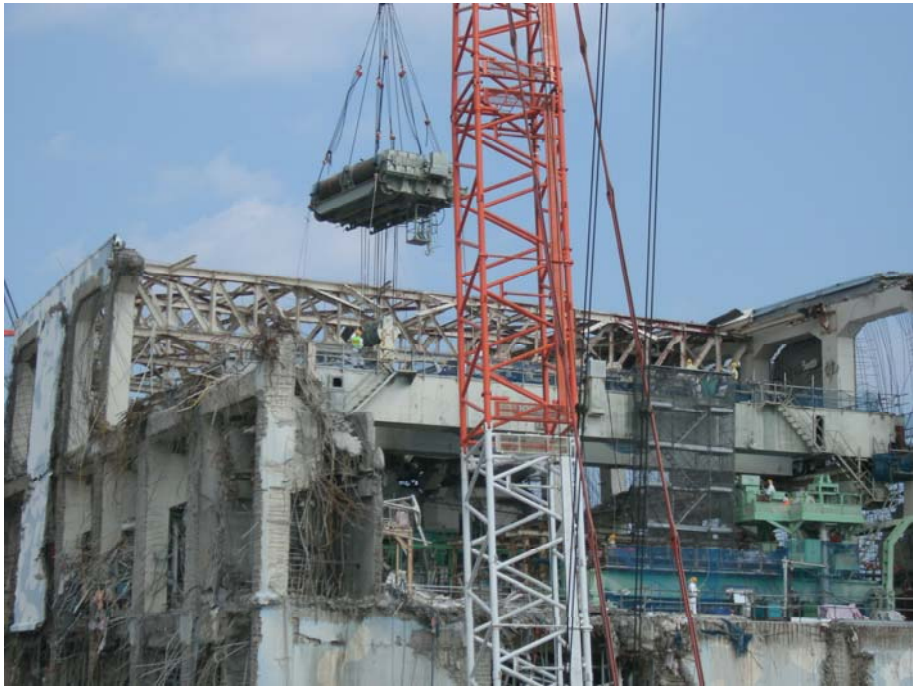
③ 天井クレーントロリー撤去作業(1)
