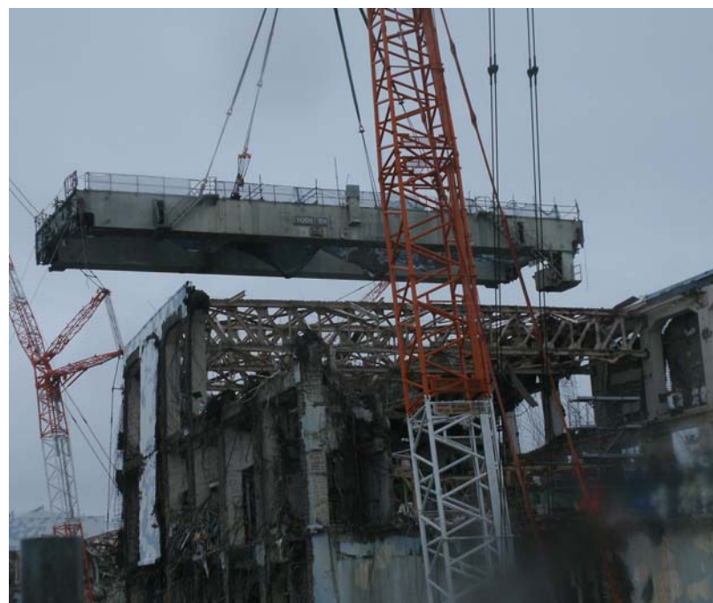
⑥ 天井クレーンガーダー撤去作業(2)
