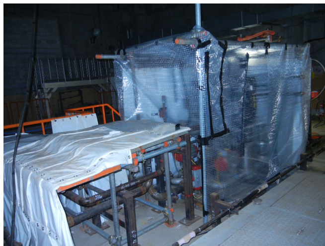
シート養生設置状況
