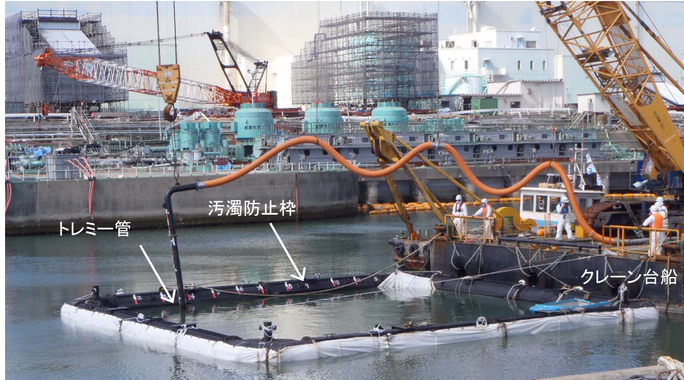
① 1～4号機取水路前面エリアでの現地試験施工の様子 平成24年2月28日
