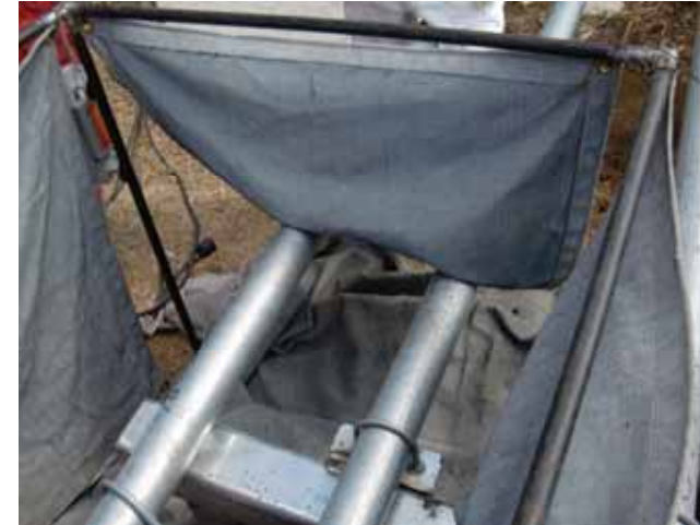
原因となった火気養生
