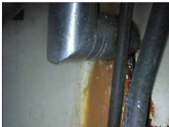
集中環境施設廃棄物系共通配管ダクト 流水確認部(指3本分で変化なし)
