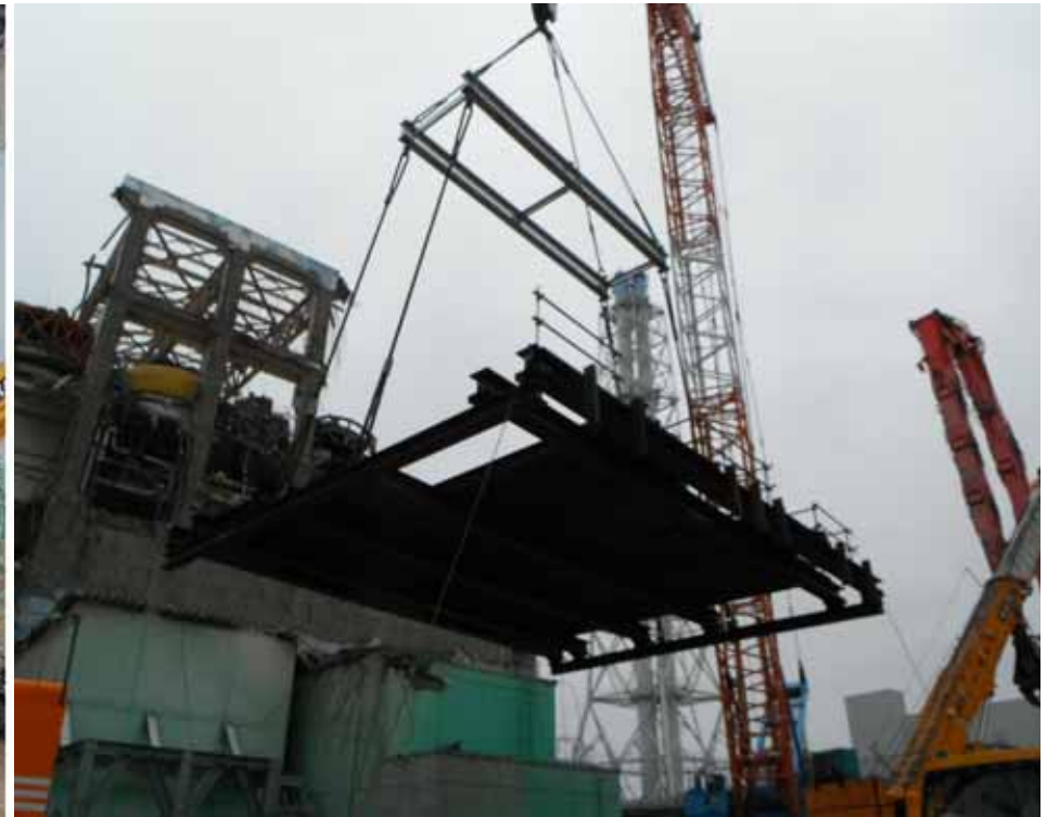
吊り上げ作業
