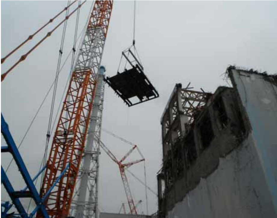
吊り上げ作業
