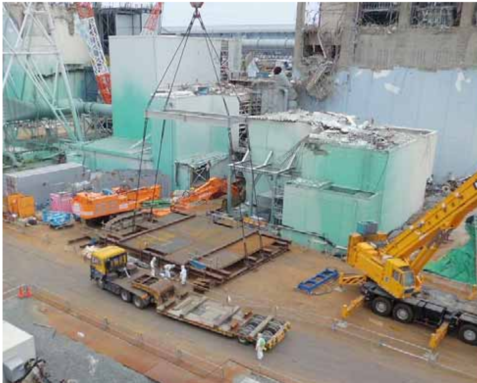
吊り上げ作業前
