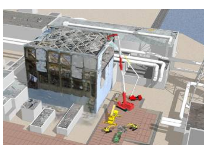
原子炉建屋上部のガレキ撤去
