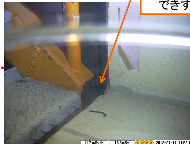
トーラス室入口
