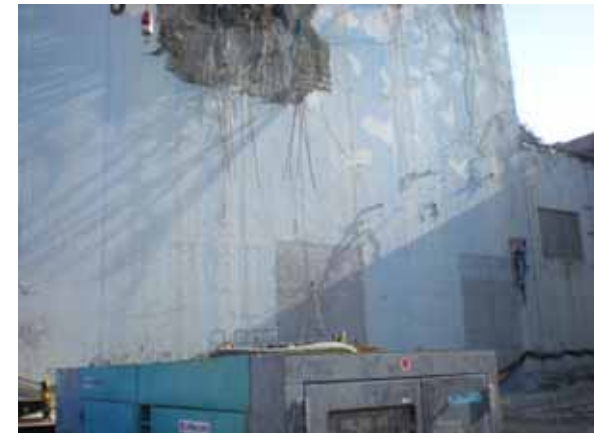
⑥ 南面（外壁）
