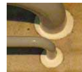
建屋貫通口の防水化
