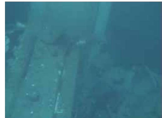
画像：ジブクレーンと対象H鋼端部
