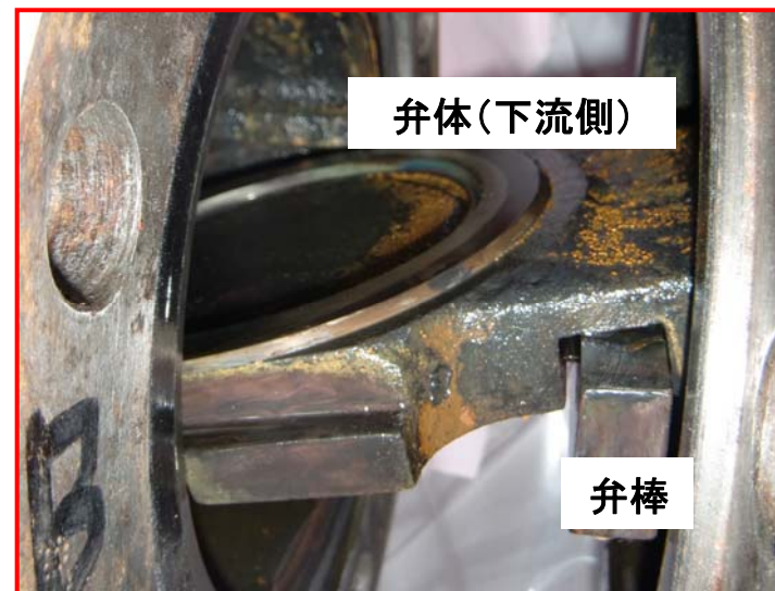
弁分解時の弁体（下流側）と弁棒の接続部
