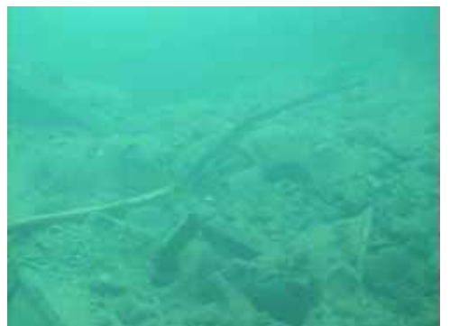
画像：使用済燃料ラック上部の堆積物
