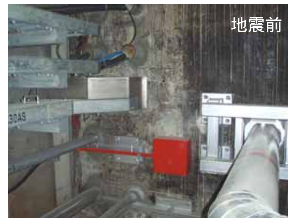
③ 接続ピット内部状況
