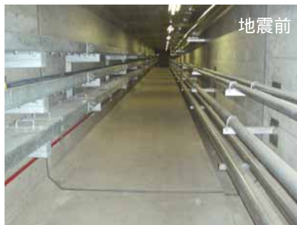
② ダクト内部状況
