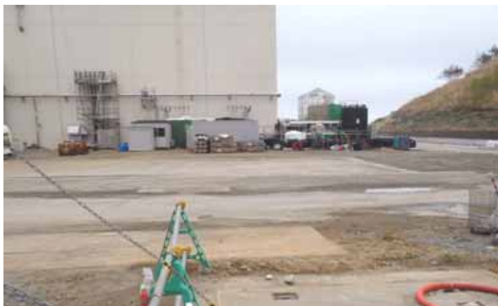
① 地上部周辺状況
