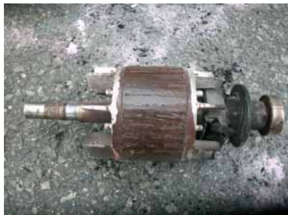
<Gポンプ電動機内部（回転子）>
