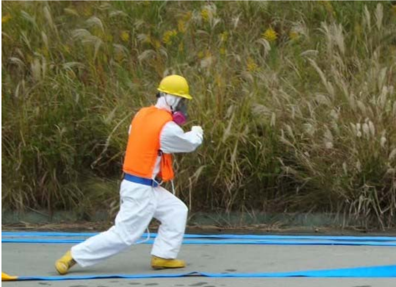
① 消防ホースを敷設している状況
