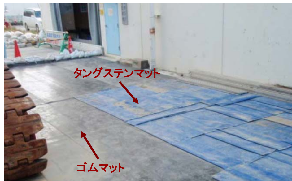
遮へい設置状況
