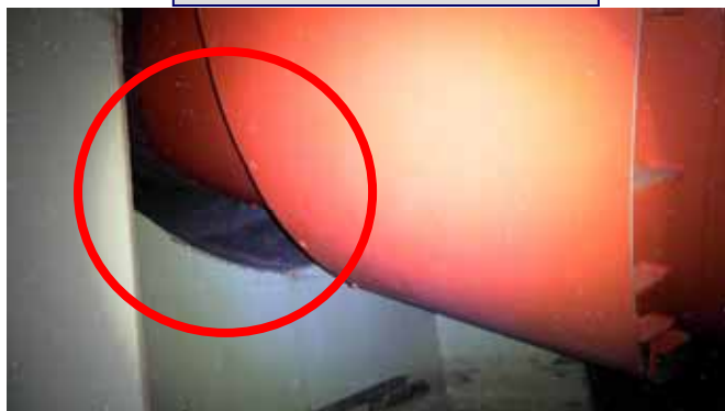
ベント管スリーブ端部
