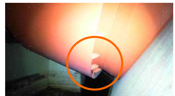
ベント管ベローズカバー下部
