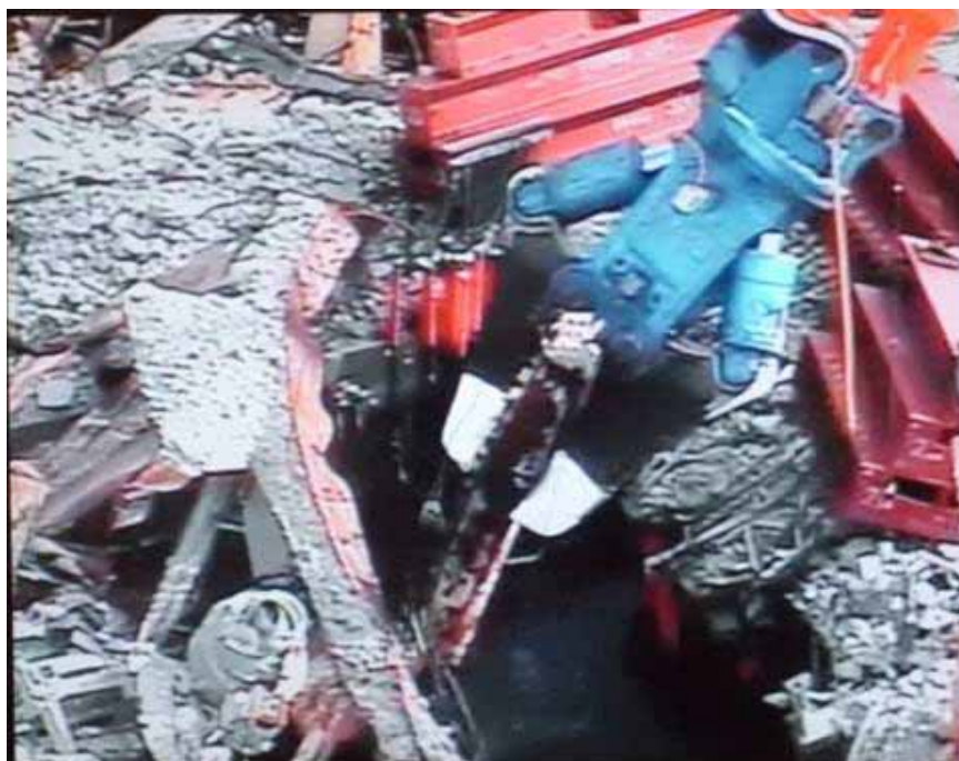
水没した鉄骨がれき （吊上げ時）
