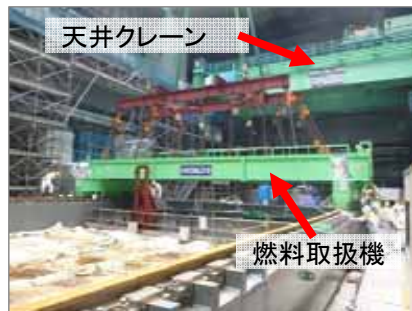
燃料取り出し用カバー内部
