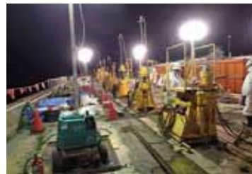
< 地盤改良工事 >
