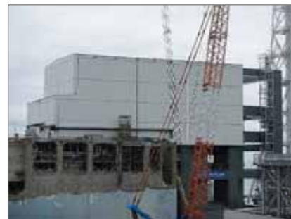
燃料取り出し用カバーの外壁
