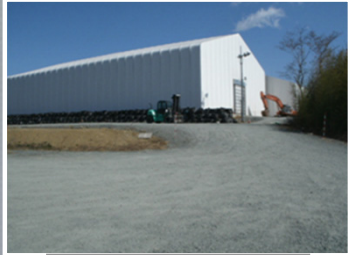
瓦礫保管テント
