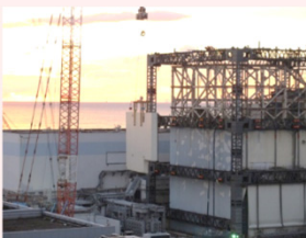
<壁パネル取り外し状況>
