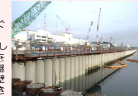
海側遮水壁 鋼管矢板打設完了状況
