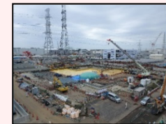
H1東エリア解体後の様子
