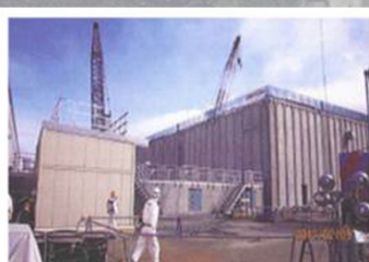
廃スラッジ一時保管施設
