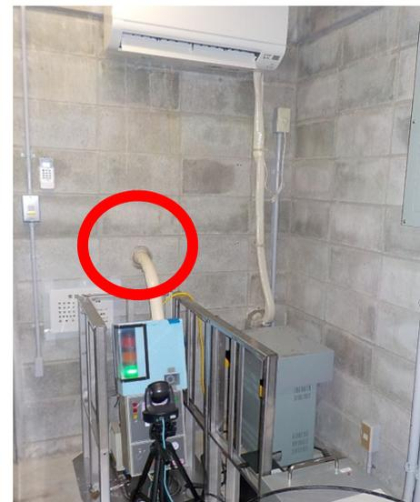
局舎の壁に穴をあけ、貫通孔から最短距離で吸気できるようにした (MP8)
