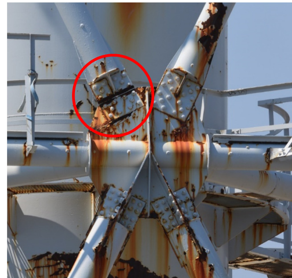
東面(GL+45m付近)
