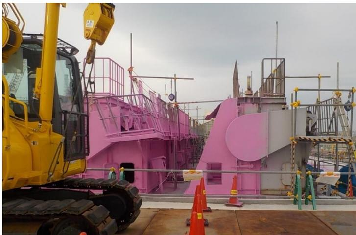
集水タンク増設（2号機除塵機撤去前）
