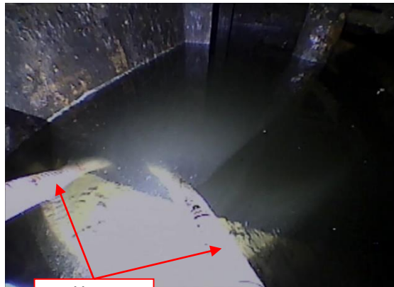
水抜き用 のホース
