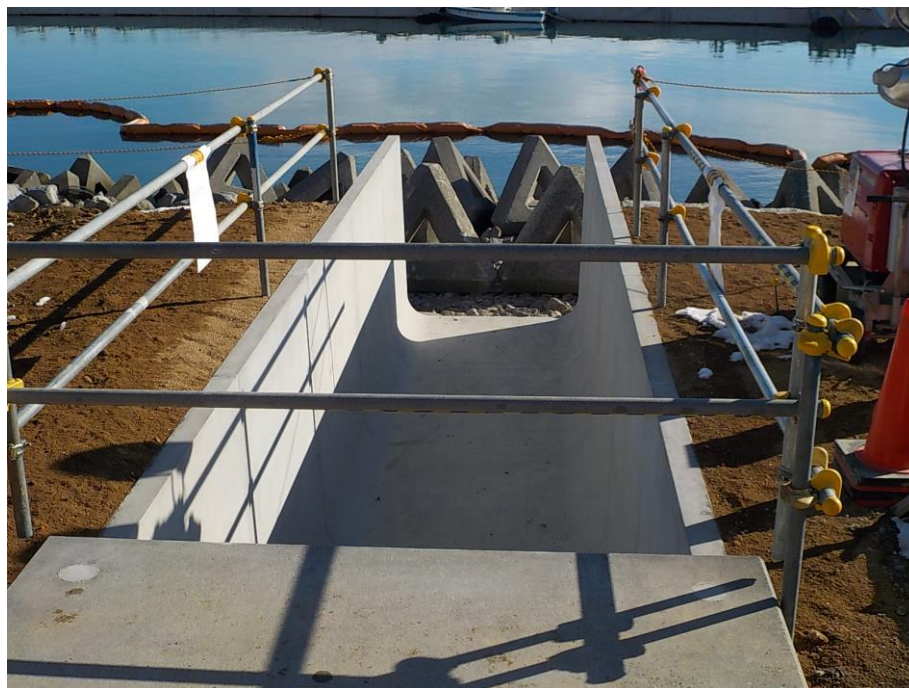
工事の状況 (流末部の状況：2月1日現在)
