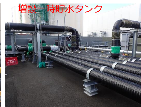
増設一時貯水タンク 排水・攪拌・受入ライン
