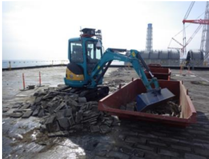
《遠隔重機による屋根保護層撤去状況》
