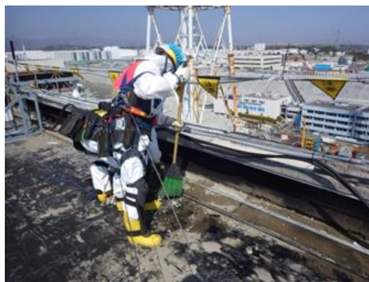
⑤屋根保護層清掃状況
