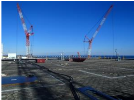
①遠隔重機による屋根保護層撤去作業前の状況
