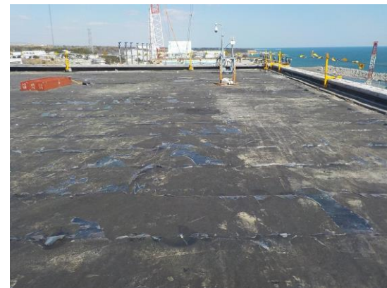
③遠隔重機による屋根保護層撤去作業後の状況
