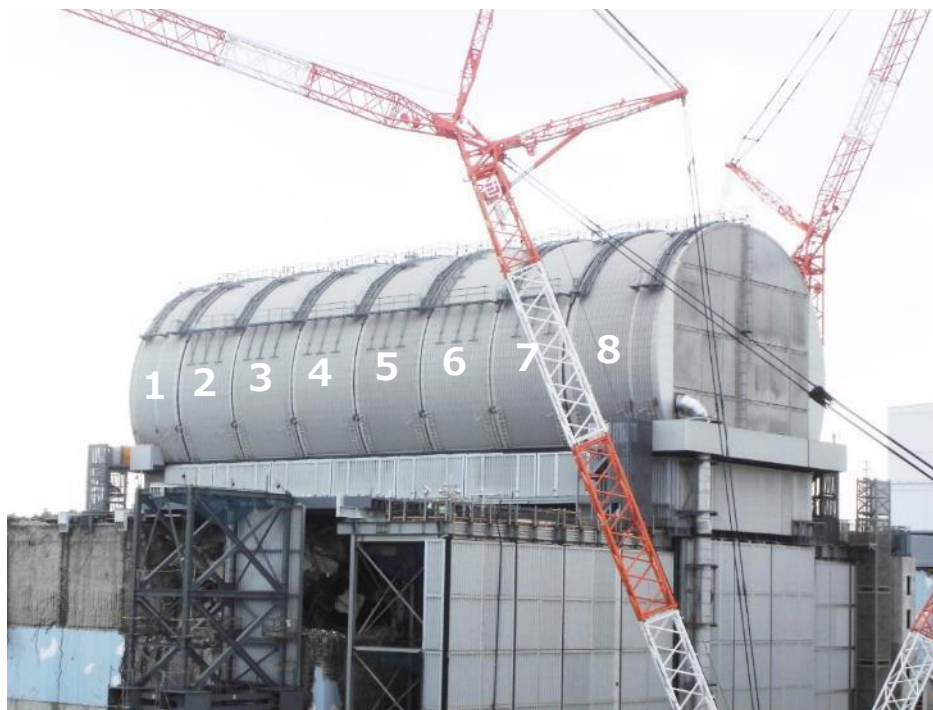
ドーム屋根7：設置完了
