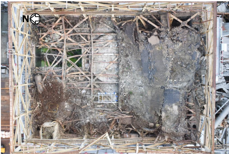
2017年11月 (カレキ撤去着手前)
