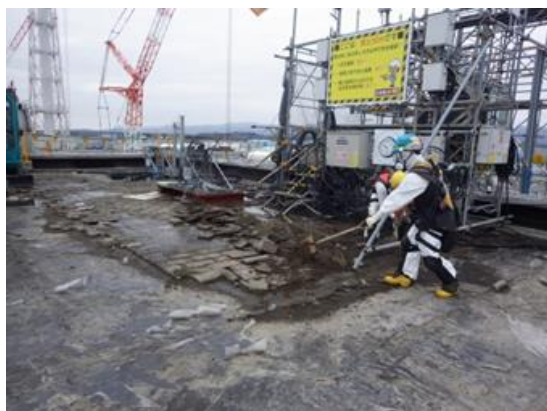
④有人による屋根保護層撤去状況
