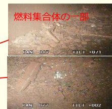
ペDESTAL底部の状況
