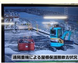
遠隔重機による屋根保護層撤去状況
