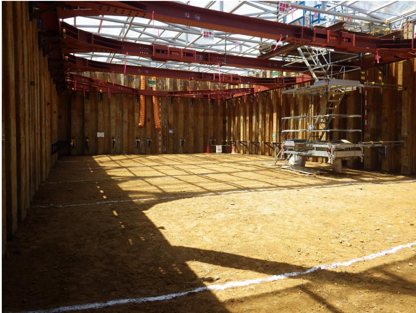
床付け面状況
