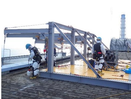
屋上外周部の笠木等撤去状況
