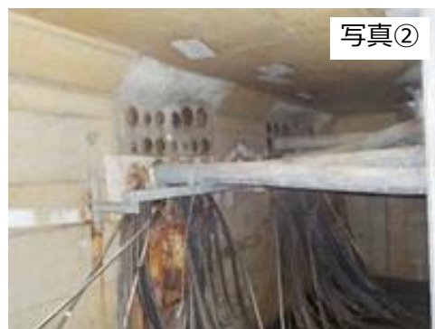
建屋貫通箇所の状況 (2018年4月9日撮影)
