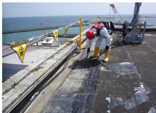
屋上残砂清掃まとめ状況
