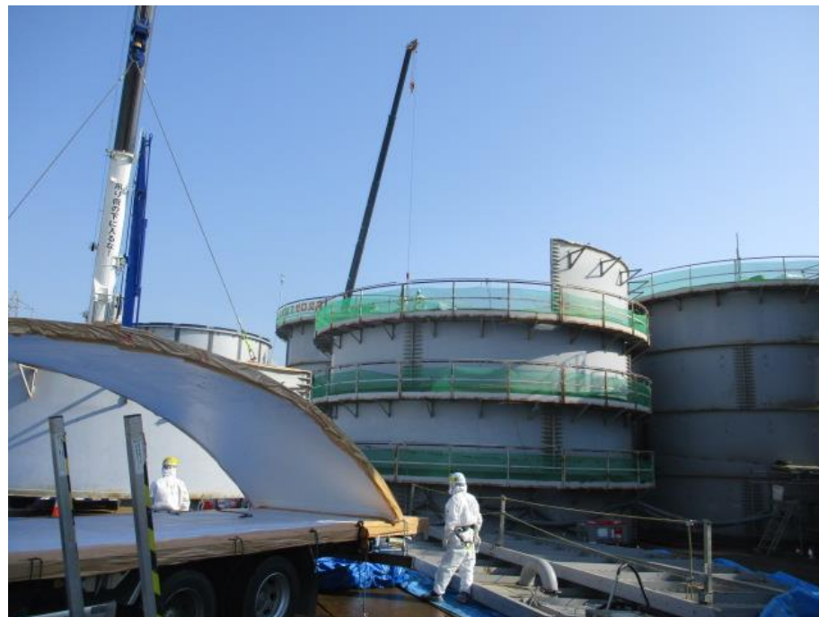
H6北エリア フランジタンク解体状況
