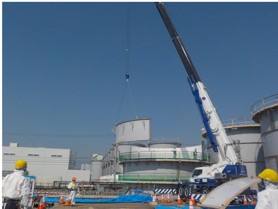
H5北エリア フランジタンク解体状況
