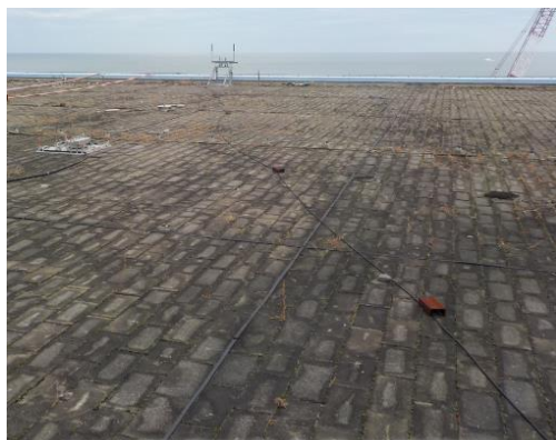
屋上保護層撤去着手前状況
