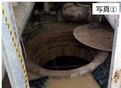
トレンチのマンホール (2018年4月9日撮影)
