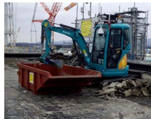
遠隔重機ルーフブロック・砂撤去状況
