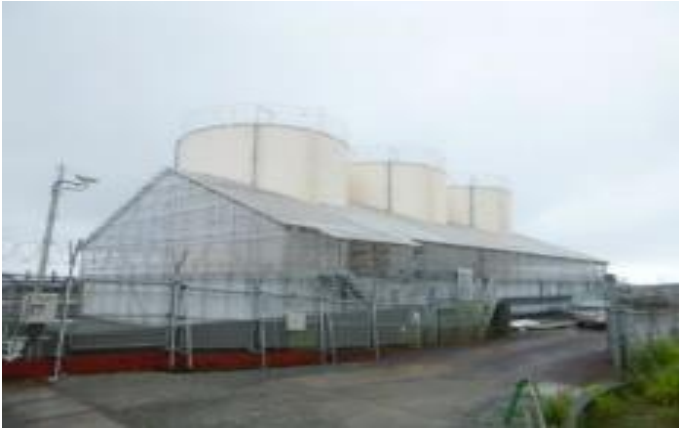
既設集水タンク
