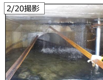
ポンプ稼働前の集水桝の状況
