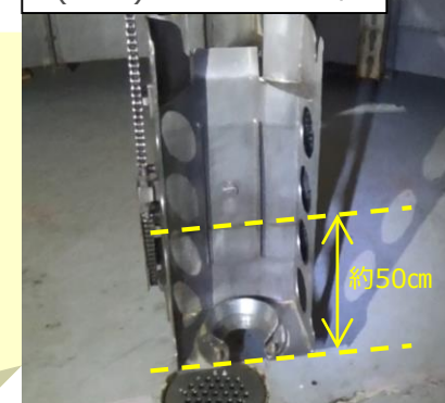
CRD交換機昇降台車にて、堆積物が埋まってい ると見られる高さ
