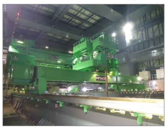
②燃料取扱機・クレーン設置状況 (オペレーティングフロア北側より撮影)
