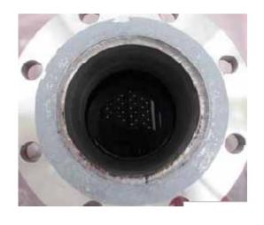
フランジ シート面に 腐食なし
