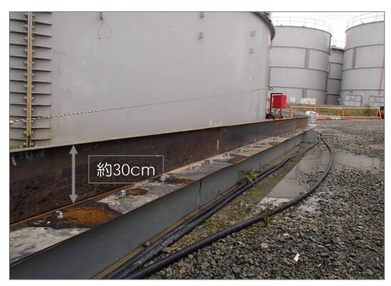
鋼製板による堰の設置状況(H4北エリア)
