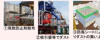
①飛散防止布敷設 ②吸引器等でダスト(塵・ほこり)を除去 ③防風シートによりダストの舞い上がり防止
