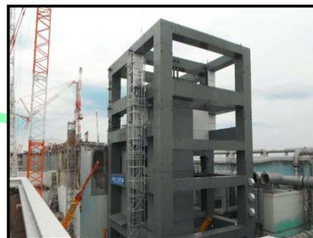
③原子炉建屋上部を除く鉄骨建方完了
