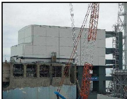
⑦外壁・屋根パネル設置完了
