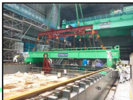
⑥燃料取扱機 部材据付け
