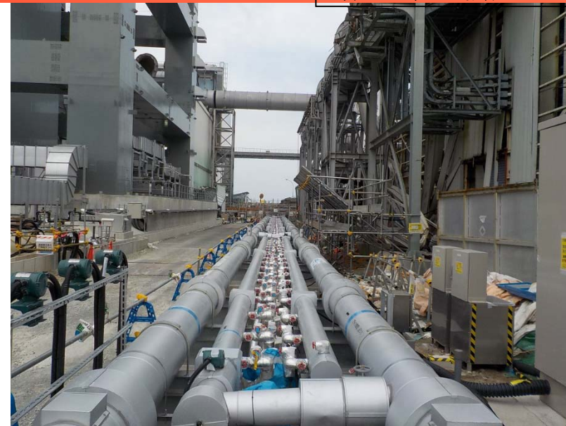
山側（4号機建屋南側）施工状況
