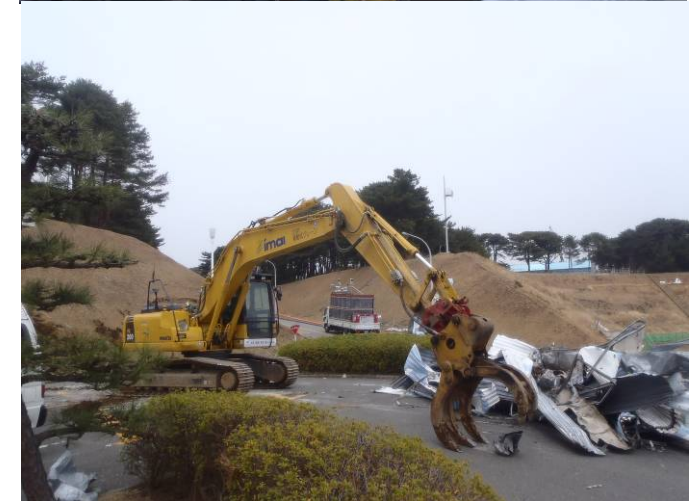
地面でのガレキ撤去
