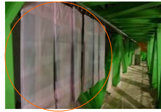
4号機燃料交換機への遮へい体設置の様子
