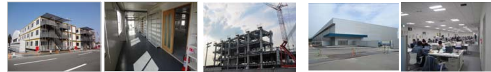
仮設休憩所と建設中の大型休憩所
