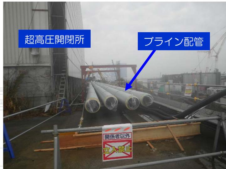
写真②：凍結プラント東側トレンチ設置状況
