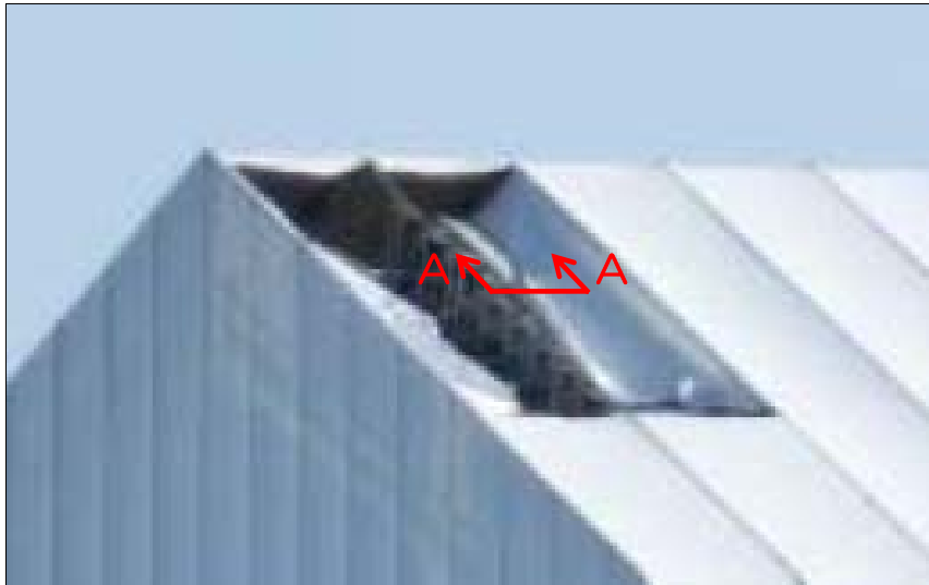
シート切断部拡大状況
