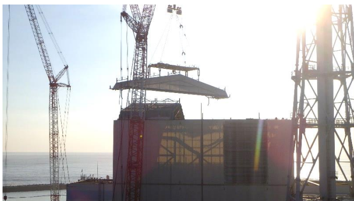
1号機建屋山側より撮影
